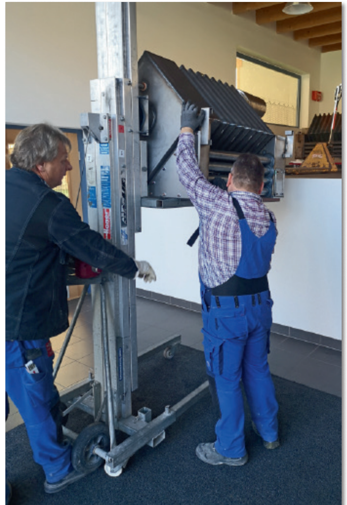
Vorbereitung zum Einbau
